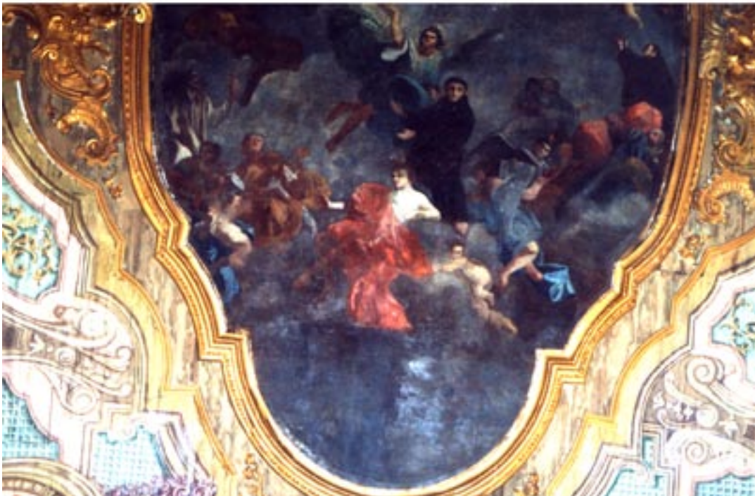
TELAIO RIPOSIZIONATO A SOFFITTO
